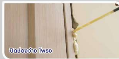
ปิดรอยติดตั้งวงกบ ประตูหน้าต่าง
